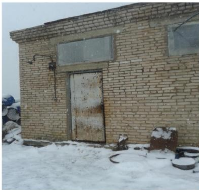
Рисунок 3. Здание водоприемного колодца
