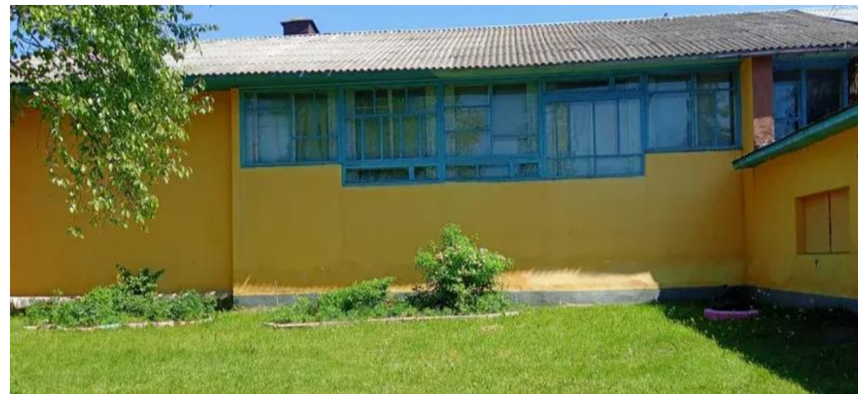
Проведен частичный ремонт здания Сергеевского Дома культуры
