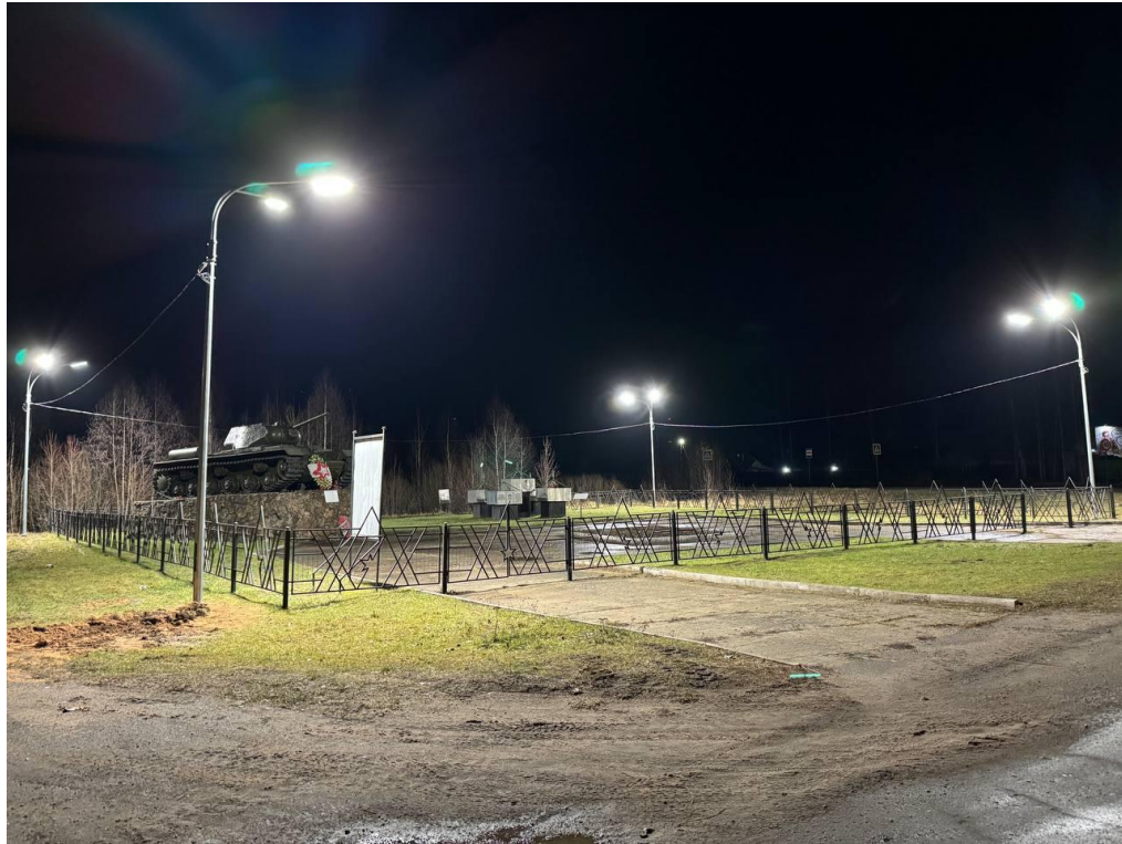
Установка опор уличного освещения у Памятного знака Танк КВ-1С
