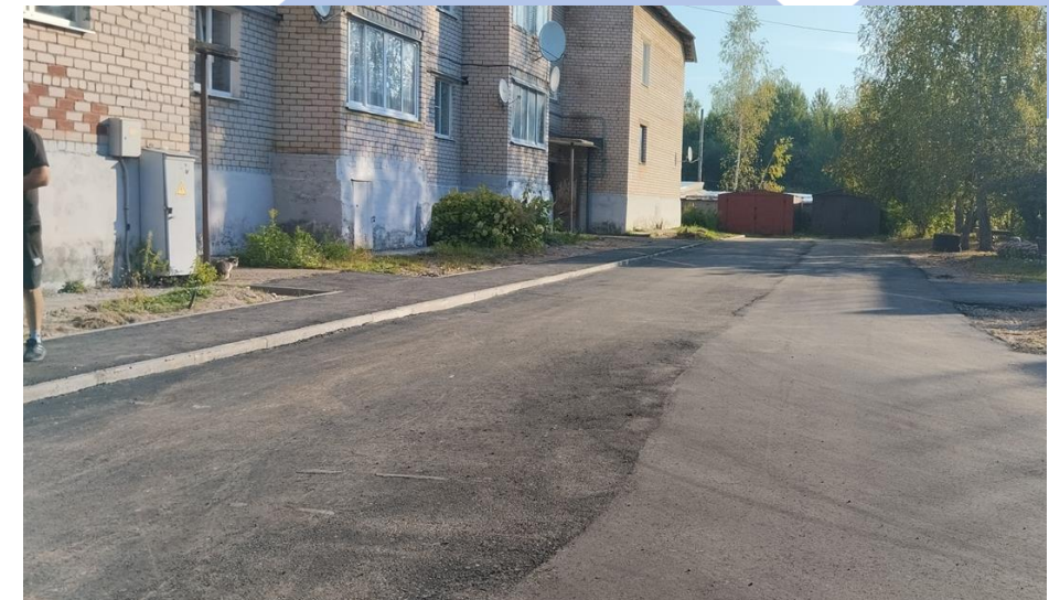
ул. Строительная, д. 206
