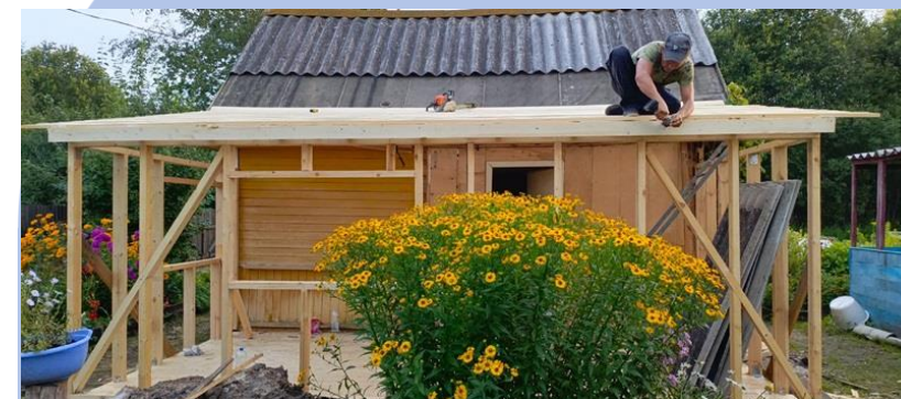
ИП Константинов М.В. социальный контракт заключен на ремонтно- строительные работы готовление металлоконструкций
