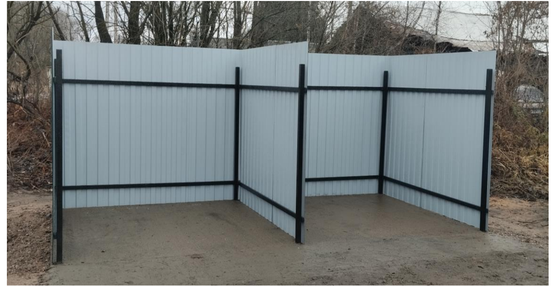
Установка контейнерной площадки ул. Кирова, д. 26
