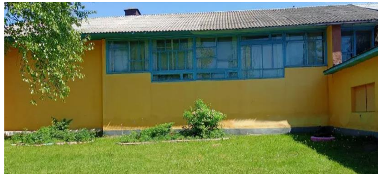
Проведен частичный ремонт здания Сергеевского Дома культуры
