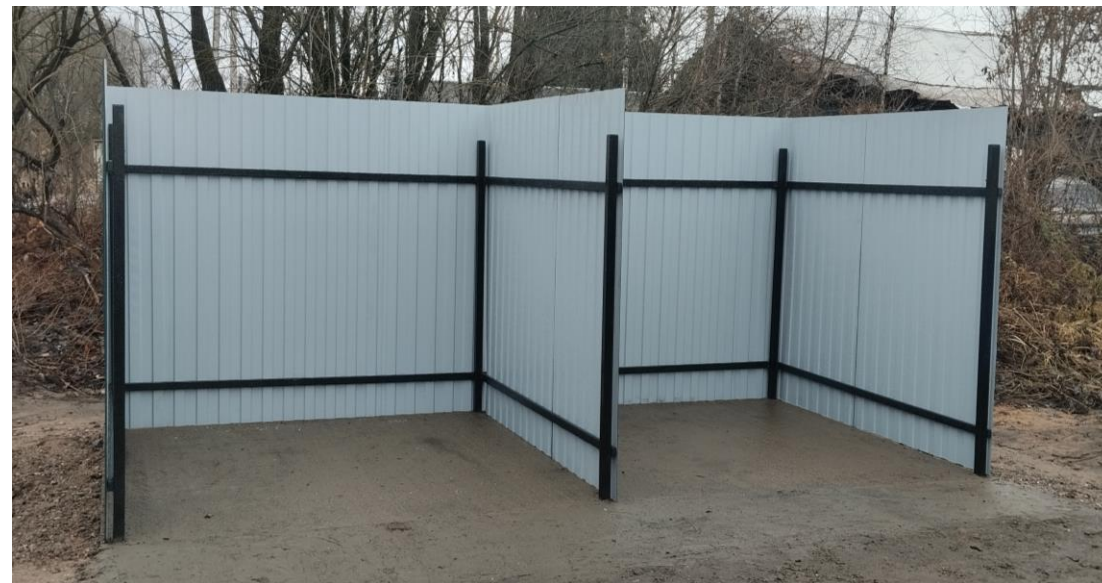
Установка контейнерной площадки ул. Кирова, д. 26
