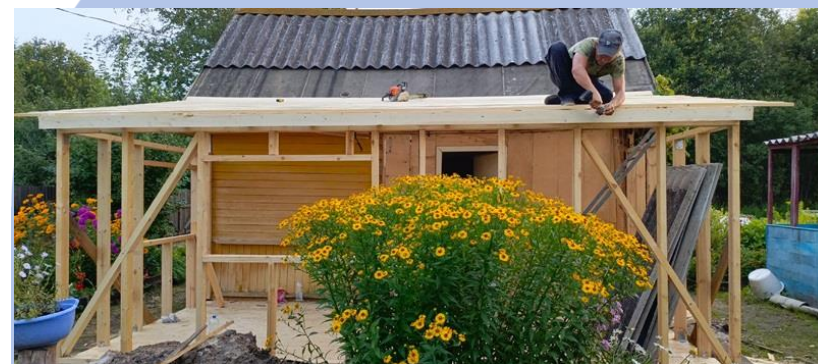
ИП Константинов М.В. социальный контракт заключен на ремонтно-строительные работы и изготовление металлоконструкций
