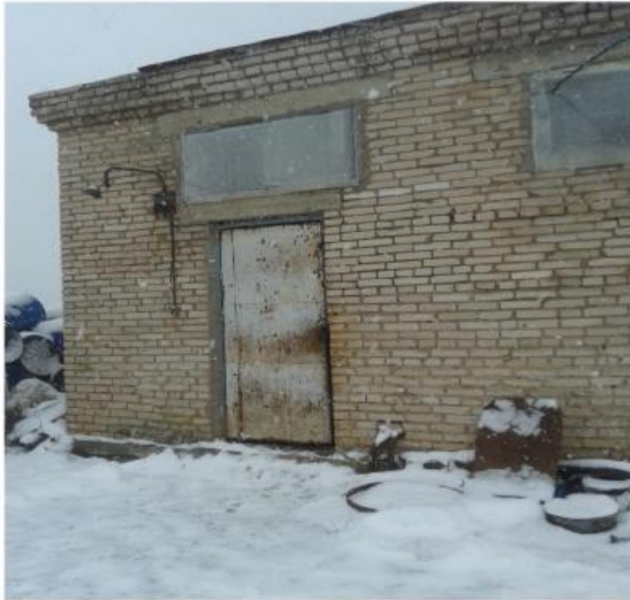
Рисунок 3. Здание водоприемного колодца
