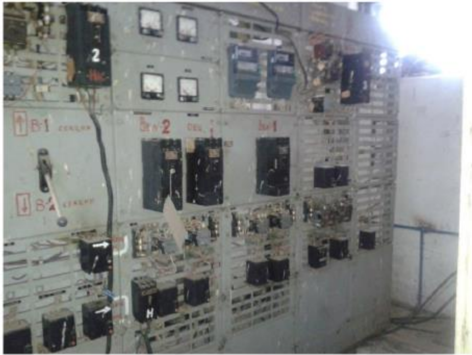
Рисунок 5. Электрооборудование НС
