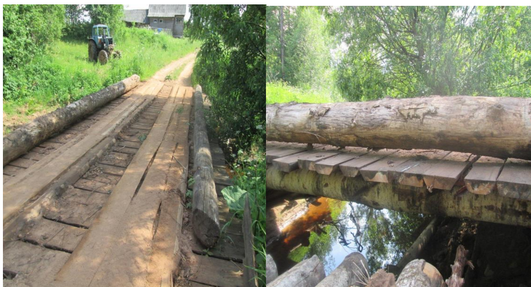
Рис. 5. Мост по дороге до д. Малые Бучки
