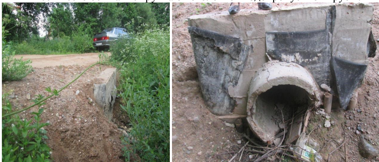
Рис. 1. Устройство железобетонной трубы на дороге Юрьево- Березицко
