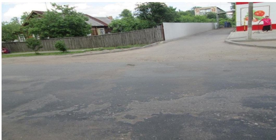
Рис.6. ремонт ул. К. Маркса.
